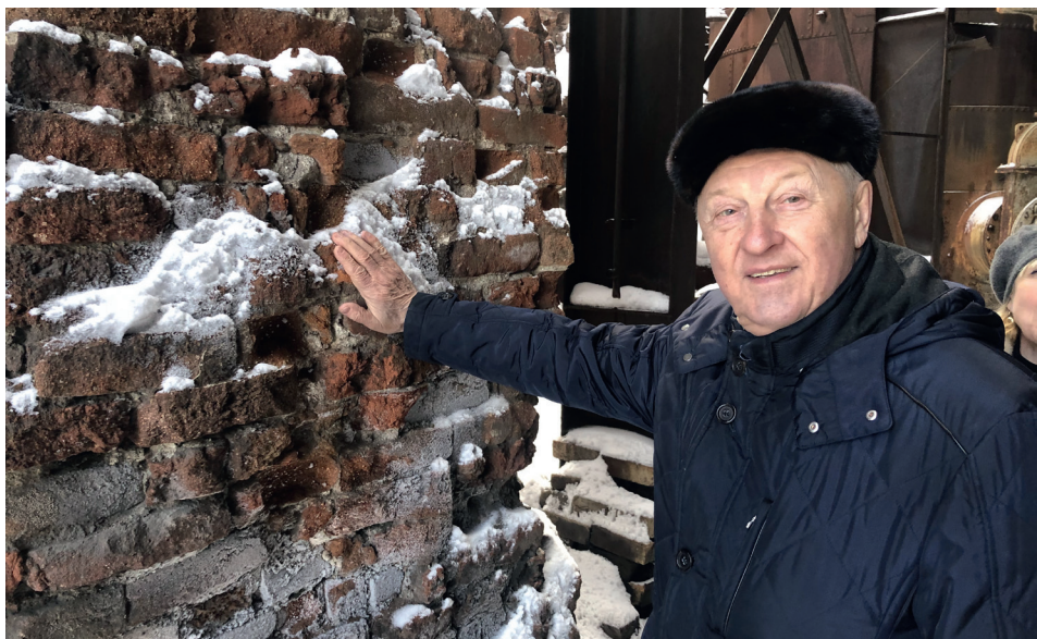
На Старом Демидовском заводе в Нижнем Тагиле (завод-музей, часть НТМЗ «Горно-заводской Урал»).
